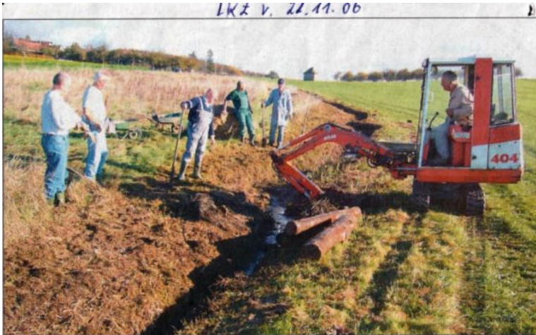
Mit dem Minibagger wurde der geradlinige Bachverlauf korrigiert.
